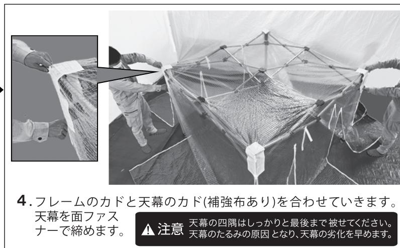
4. フレームのカドと天幕のカド(補強布あり)を合わせていきます。天幕を面ファスナーで締めます。▲注意 天幕の四隅はしっかりと最後まで被せてください。
